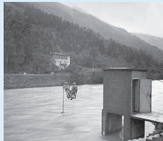
Das um ca. 1930 abgebildete Foto zeigt eine Abflussmessung an der Etsch in Töll.
